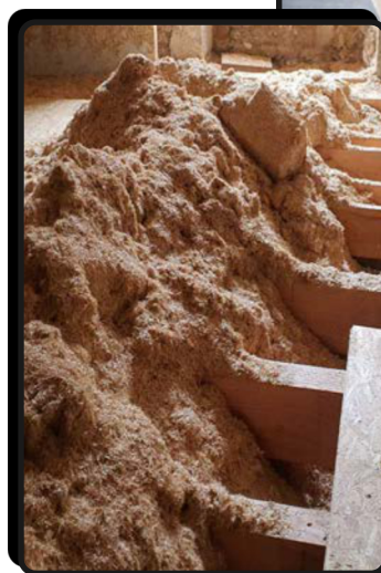
Par déversement Hors technique courante
