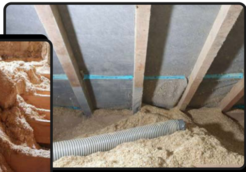
Par soufflage Hors technique courante
