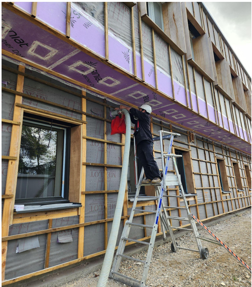
Insufflation sur chantier
