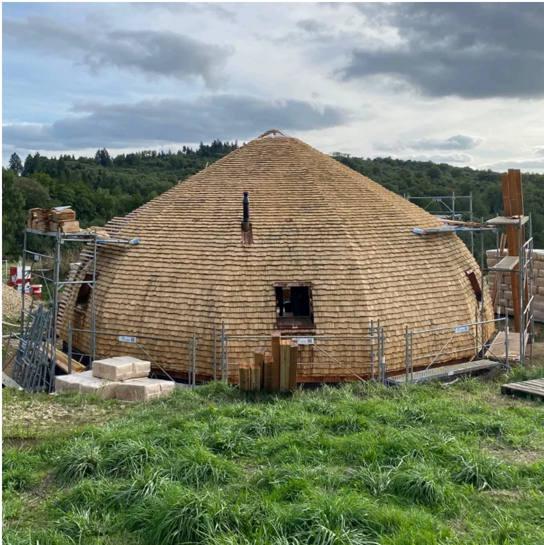
Les bardeaux en châtaignier sont durables, très résistants aux parasites et ne nécessitent pas de traitement © Corinne Mérigaud
