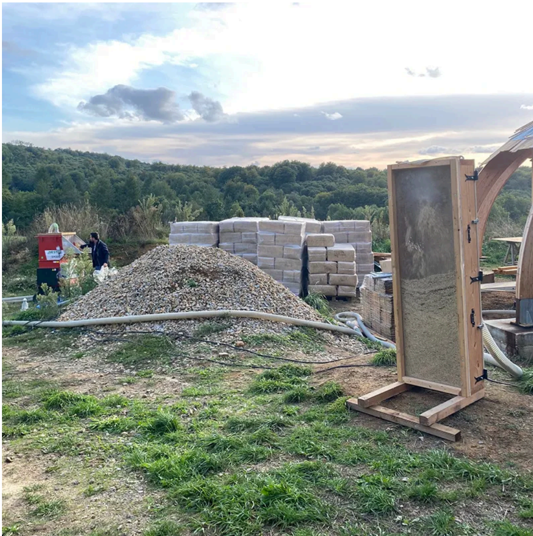
L'insufflation de paille hachée dans les caissons est très rapide et réalisée directement sur site © Corinne Mérigaud
