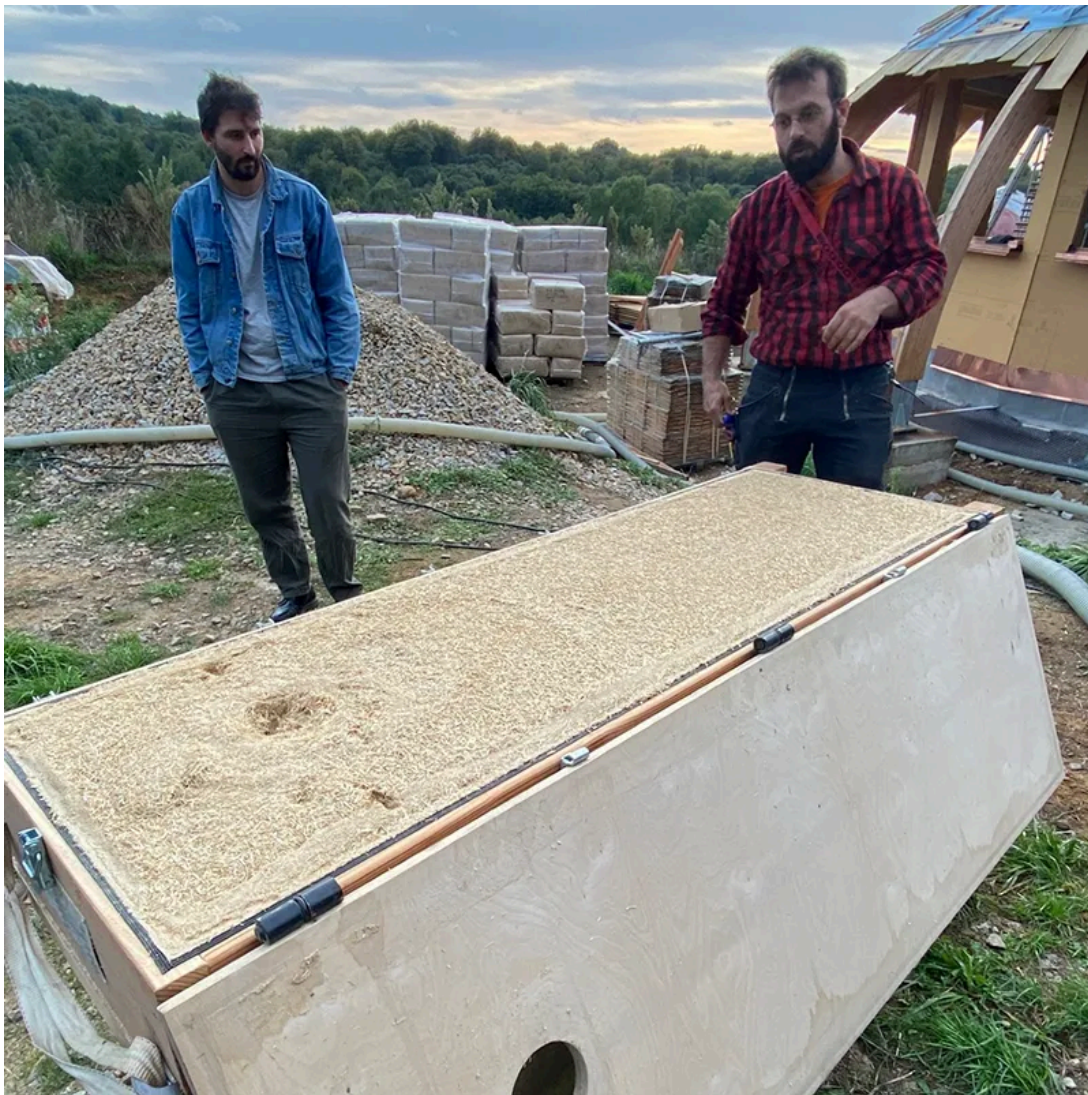
La paille hachée est produite dans la Vienne par la coopérative Iélo. Insufflée dans les caissons, elle offre des performances isolantes remarquables, même en été © Corinne Mériгаud
