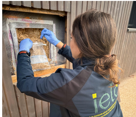
Figure 4 : Exemple de trappe de visite dans le revêtement extérieur ; Restaurant Universitaire Champlain Crous
