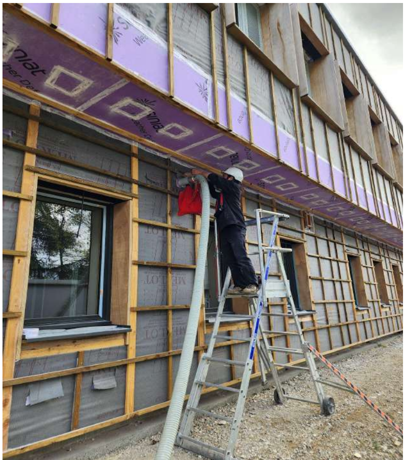
Insufflation sur chantier
