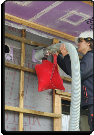
Par insufflation (ATEX de cas a validé pour les parois verticales)
