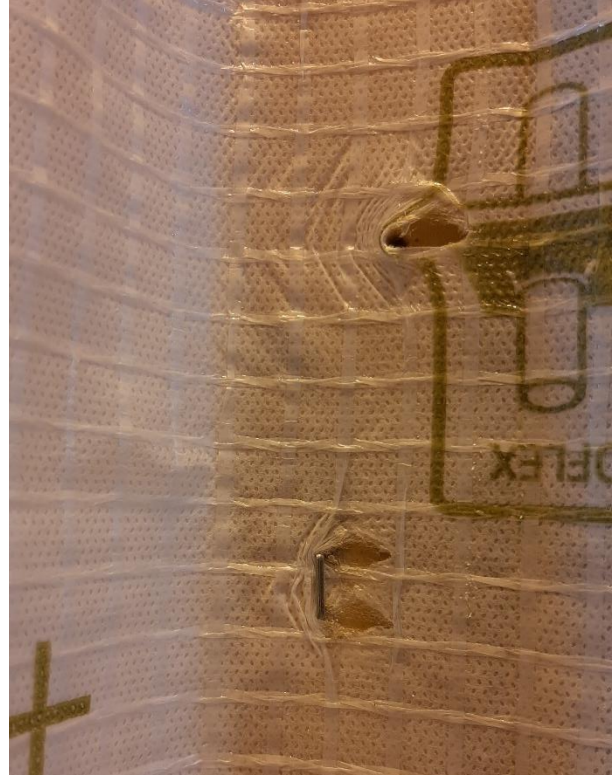
Photos 8, 9, 10, 11 : Pare-vapeur après démontage des tasseaux verticaux
