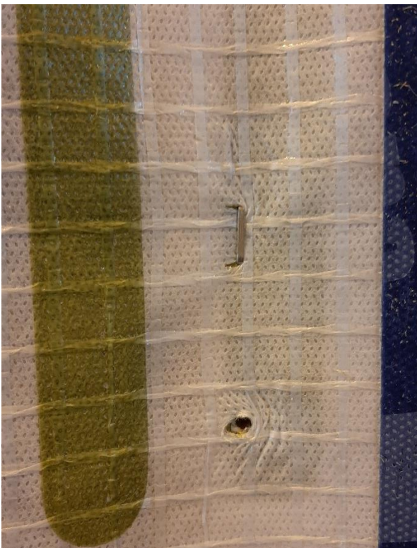
Photos 8, 9, 10, 11 : Pare-vapeur après démontage des tasseaux verticaux
