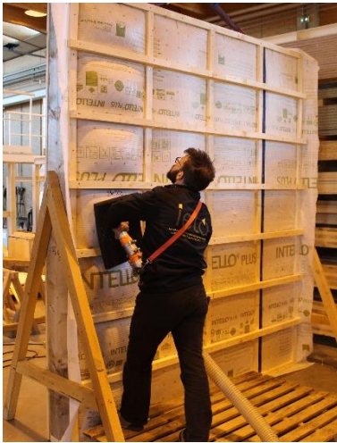
Photo 5 : remplissage de la paille hachée par soufflage – réalisé par le client
