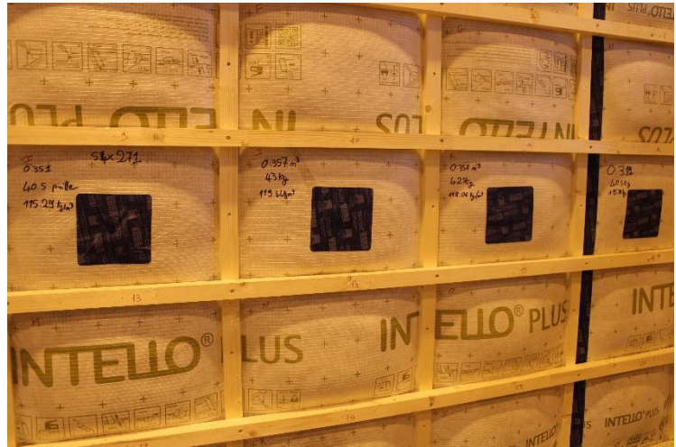
Photo 6 : cavités remplies – mise en place d'un patch TESCON VANA pour étanchéité
