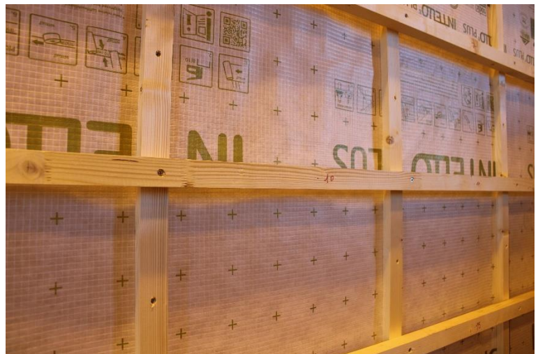
Photo 4 : Face intérieure - détails
